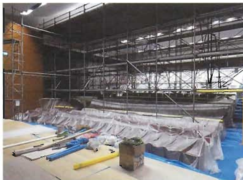
D棟講堂の工事風景
