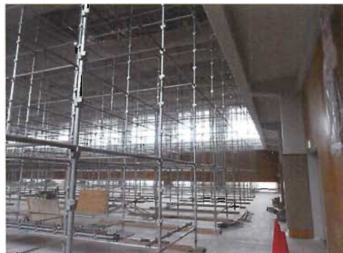
体育館の工事風景
