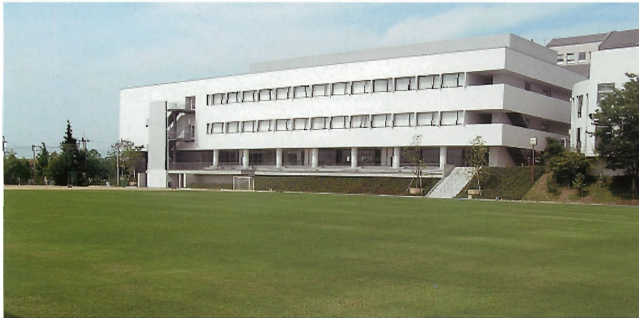
第1期芝生化工事が完了したグラウンドからD棟を臨む
