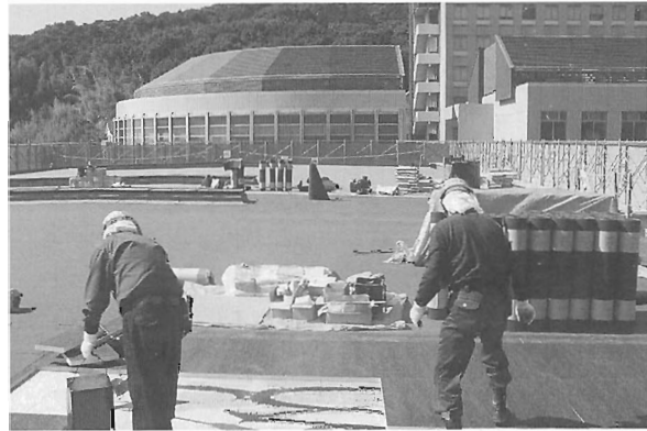
「新学舎の工事風景（屋上）」
