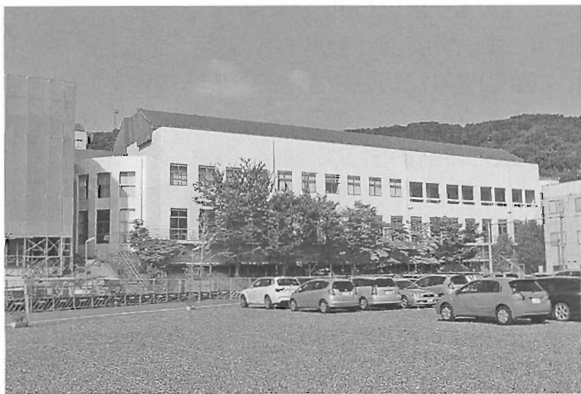
「外壁補修が完了した大学会館」
