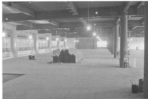
「新学舎の工事風景（3階）」
