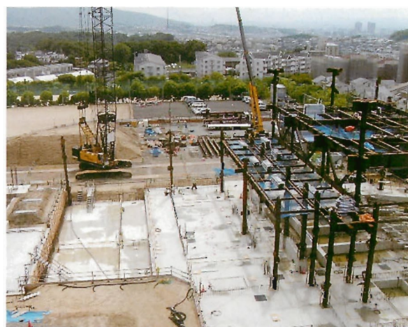
工事風景（H20.6.4現在）
