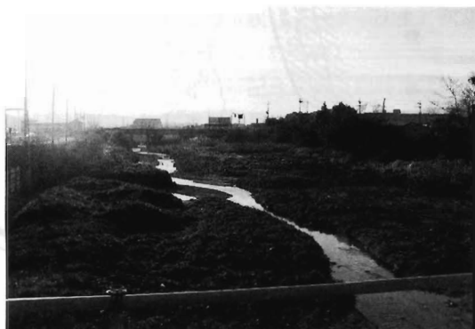
写真1 狭山池に注ぐ西除川（向うに狭山池橋が見える）昔の面影を残し、土提のままである。改修工事で狭山池は干上がり、鉄板で囲まれているため、池に注ぐ西除川の地点を見ることは不可能になっている。
