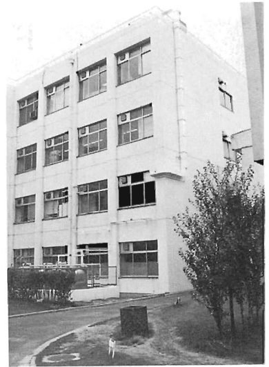
R I 実習室 (2階) と排気設備
